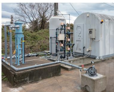
高度な浄水技術「RO膜」により浄化された「きれいな水」を飼育に使用しています。
